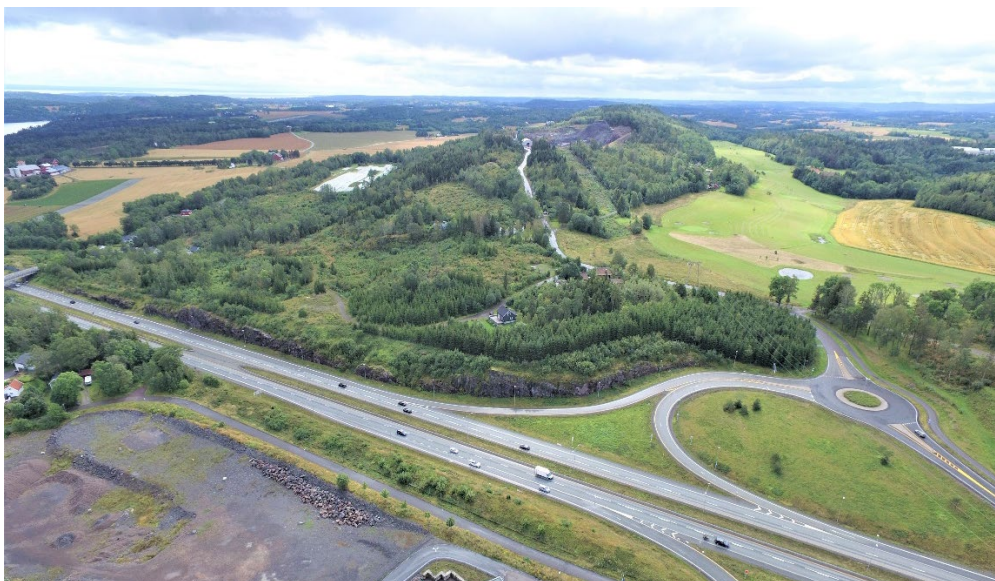
Figur 2: Flyfoto med dagens situasjon
